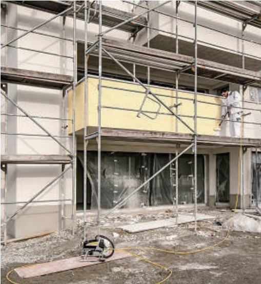
ピストン式エアレス ポンプのイメージ
